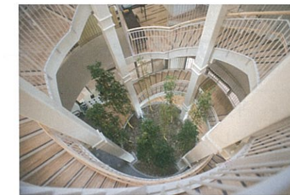
南側に設置した二重螺旋階段は伝承にちなんでダ・ヴィンチ階段と名付けられている
