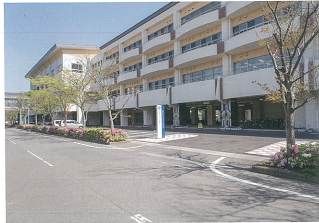
中央に正門を表すサインが立てられ、その奥にある玄関口前の柱には自然の中で学ぶことを象徴して石貼りのモザイクで昆虫が描かれている
