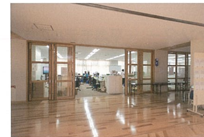
みらいホールに面した部屋はほぼ間仕切りが引戸式となっている。写真は職員室前
